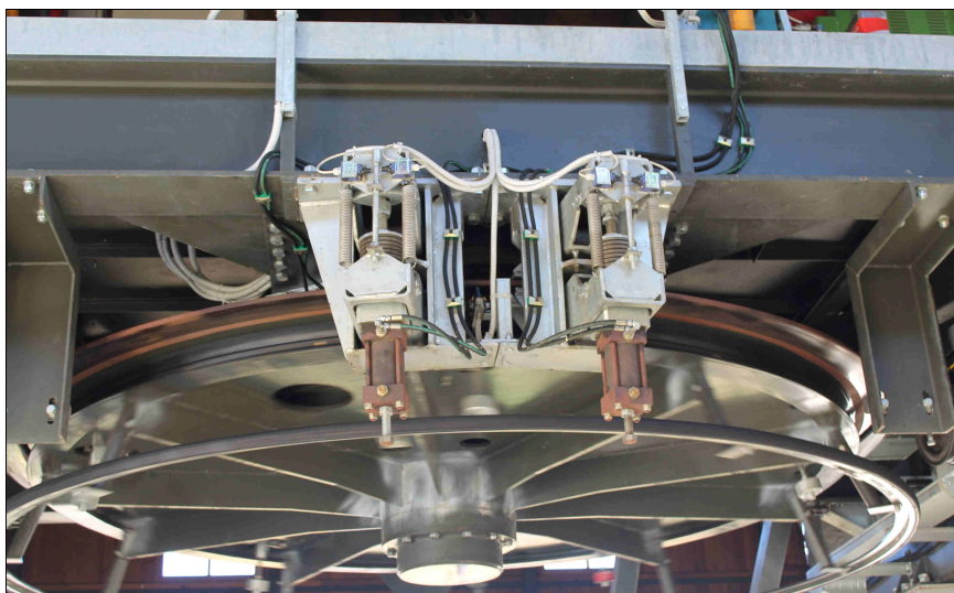
Pinze dei freni di emergenza (automatico e supplementare) agenti sulla puleggia motrice
