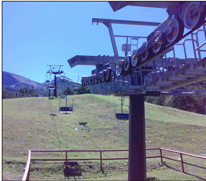
Sostegno di ritenzione alla stazione di valle
